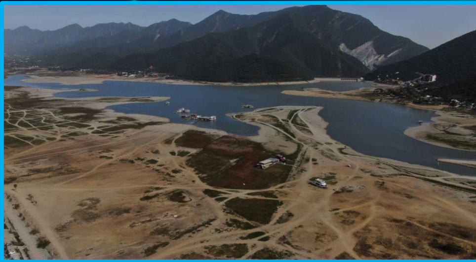
La Boca Dam, Nuevo León
